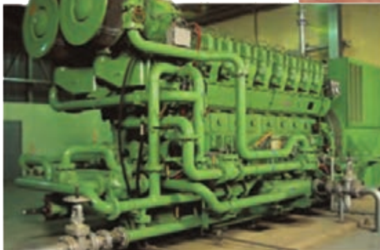
موتور ژنراتور یک نیروگاه برق اضطراری معدن
