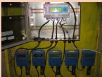
دستگاه‌های سنجنده گاز درون معدن
