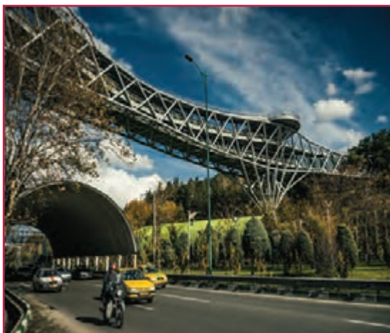
شکل ۱-۲- پل طبیعت در شهر تهران
