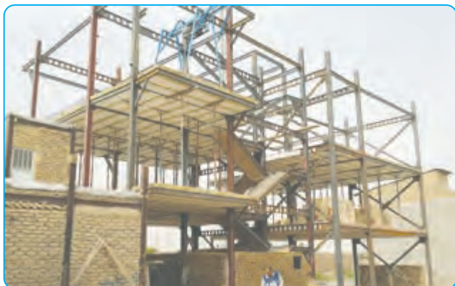
خانه‌ی در حال ساخت
