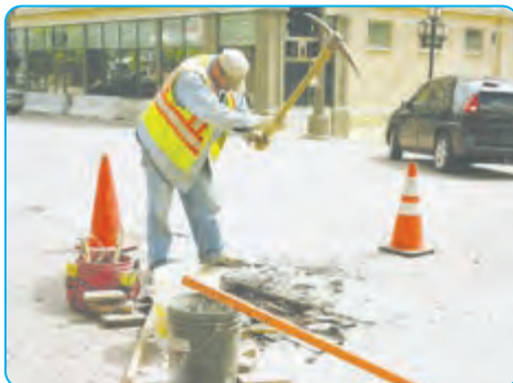
استفاده از کلنگ در کندن زمین
