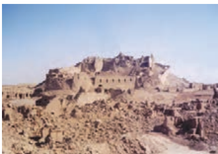
ج) ارگ بم بعد از زلزله
