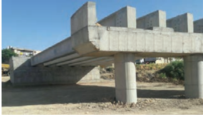
شکل ۱۲- تصویر پل نیمه تمام
