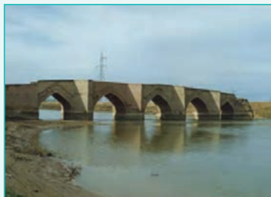
شکل ۲۶-۵- پل میرزا رسول در میاندوآب
