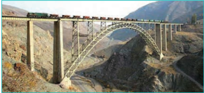
شکل ۶۶-۵- پل هوایی قطور- خوی
