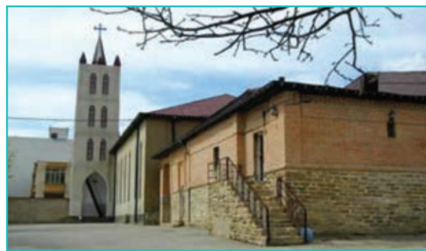
شکل ۳۹- کلیسای ننه مریم - ارومیه
