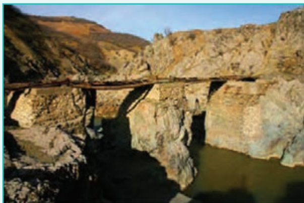
شکل ۲۷-۵- پل قالاتاسیان سردشت
