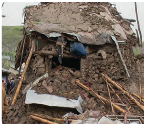
شکل ۲-۵- زلزله سال ۱۳۸۳- طالقان
