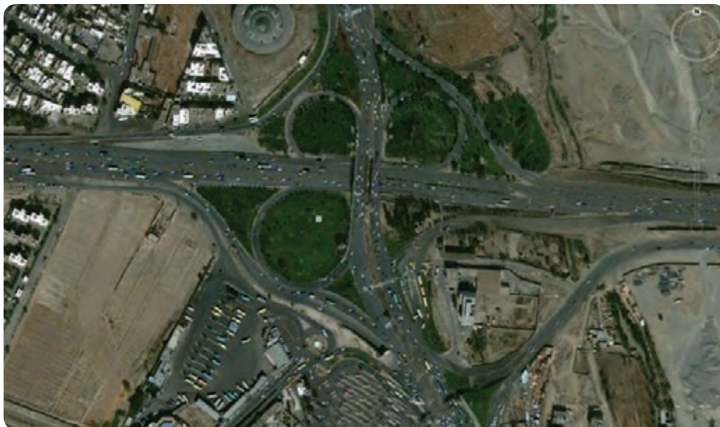
شکل ۱-۲- استان البرز پل ارتباطی غرب و شرق کشور
