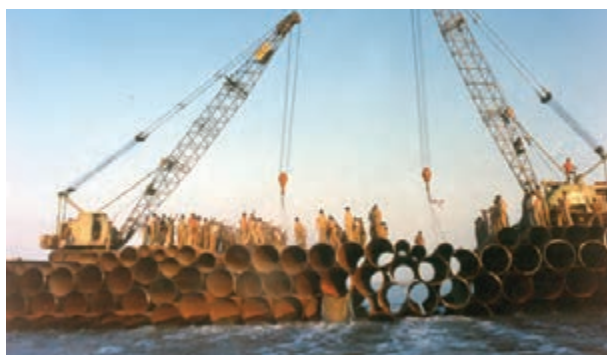
شکل ۱۵-۲- پل بعثت در داخل اروندرود، سند افتخار نیروهای مهندسی رزمی جهاد سازندگی
