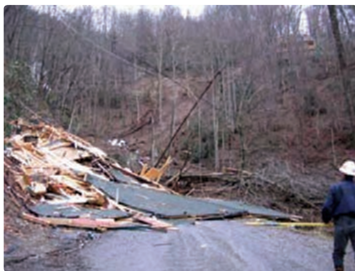
شکل ۱۲-۱- تخریب ناشی از رانش زمین
