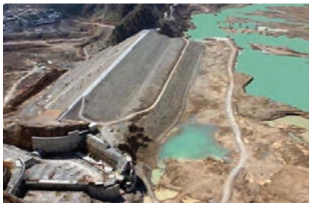
شکل ۱-۲۵- احداث سد سیوند بر روی رود سیوند
