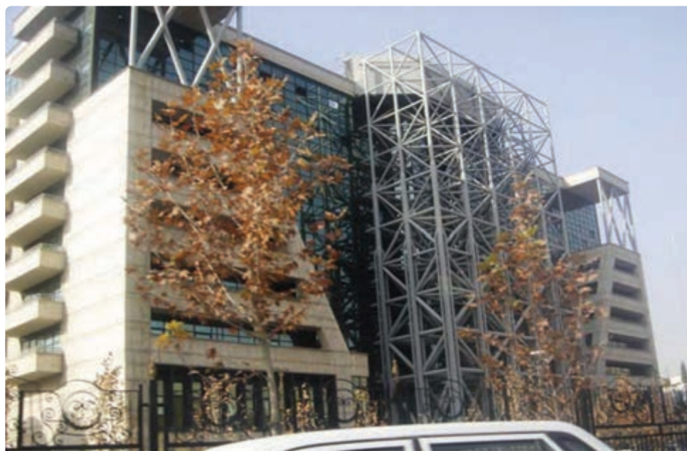
شکل ۱۲-۲- ساخت و سازهای جدید شهری
