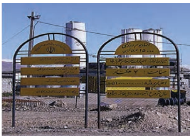
شکل ۱۰-۶- ورزشگاه ۱۵۰۰۰ نفری قزوین در حال ساخت
