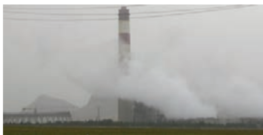
شکل ۴۸-۱- آلاینده‌های نیروگاه حرارتی
