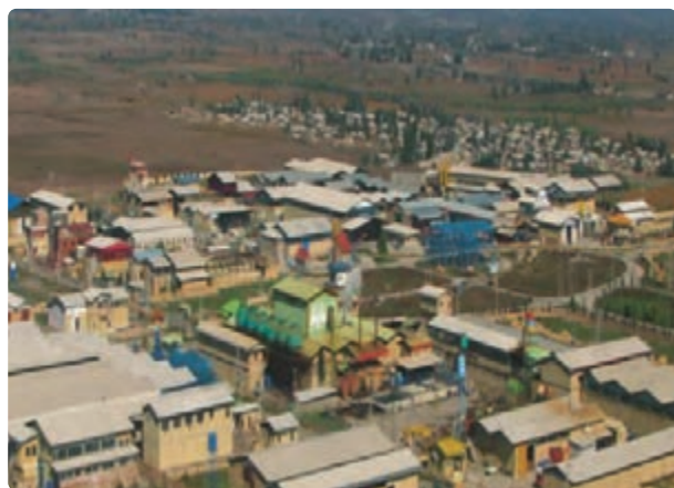
شکل ۲-۴- شهرک صنعتی علی آباد
