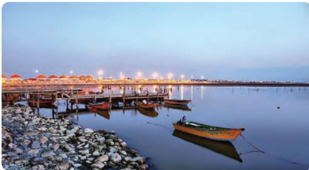
شکل ۱۸-۲- اسکله تفریحی - بندر ترکمن
