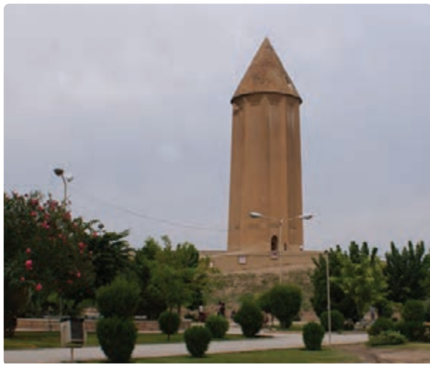
شکل ۴۰-۵- برج آجری قابوس بن وشمگیر - گنبد کاووس
