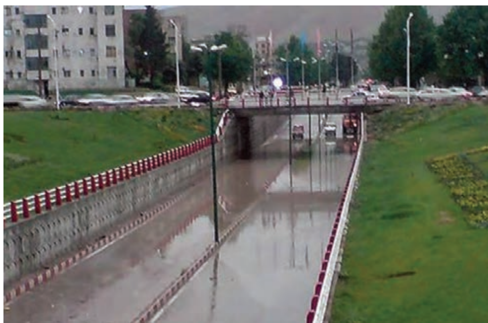
شکل ۱۰-۱۴- یکی از زیرگذرهای شهر خرم‌آباد
