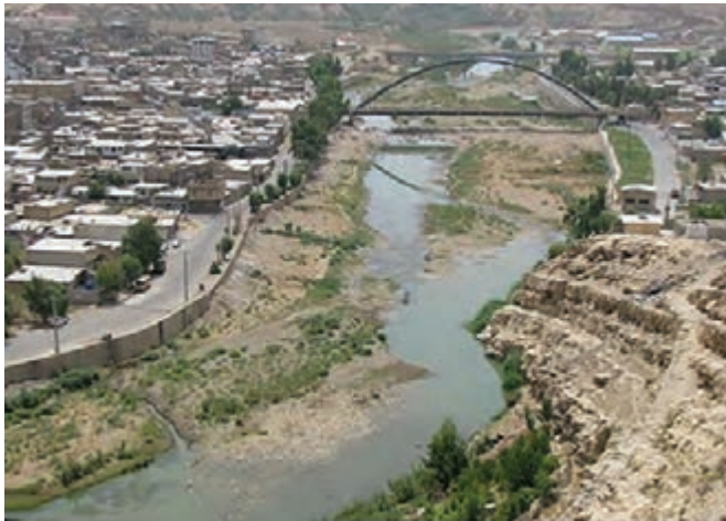
شکل ۷-۵ - خرم‌رود در فصل کم آبی
