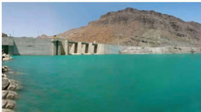
شکل ۲۱-۶- مهار آب های سطحی
