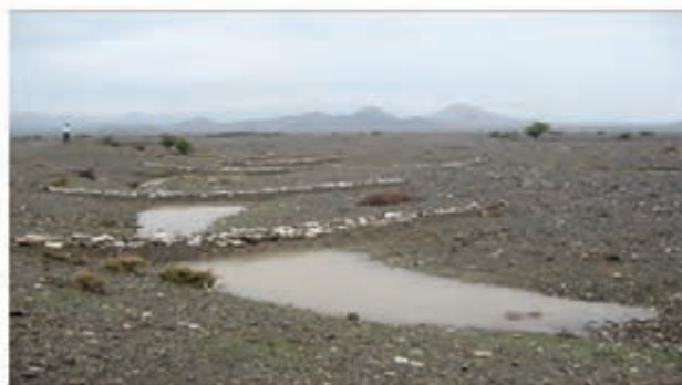
عملیات آبخیزداری احداث بندهای خشک‌چین شکل ۵۹-۱- مجموعه عملیات آبخیزداری
