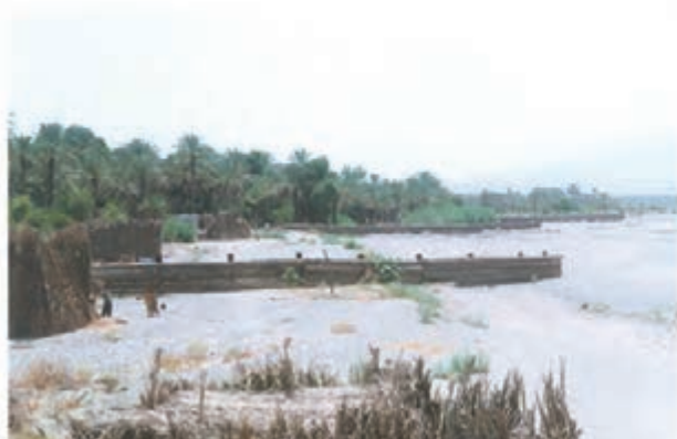
اپی‌های احداث شده با هدف حفاظت کناره‌ها
