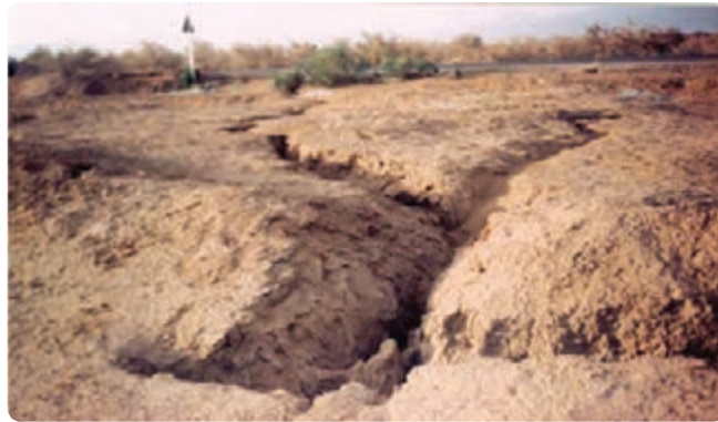
شکل ۱-۵۴- پدیده فرونشست در منطقه رضوان شهر
