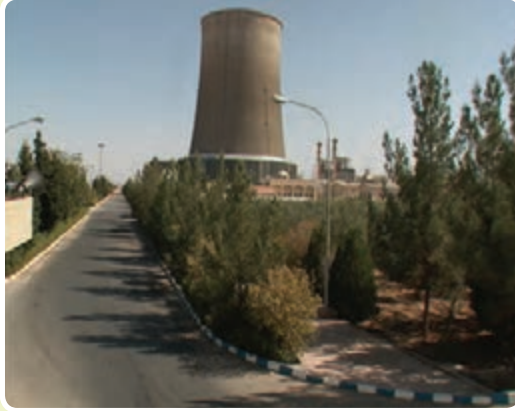
شکل ۱۰-۶- نیروگاه سیکل ترکیبی
