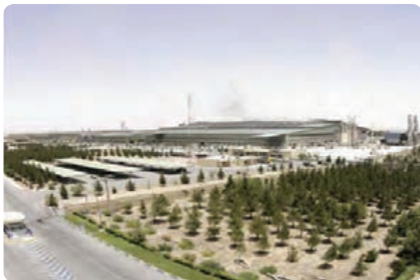
شکل ۹-۶- شرکت فولاد آلبازی اشکذر
