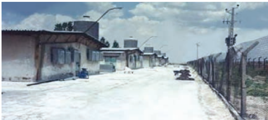
شکل ۱- حصارکشی اطراف سالن‌های مرغداری
