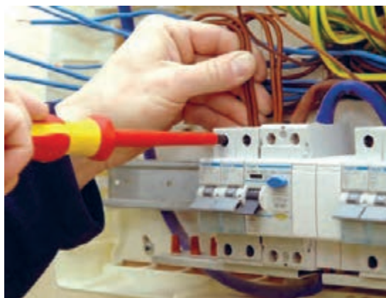
شکل ۴۸- محکم کردن سیم ها در محل اتصال به قطعه
