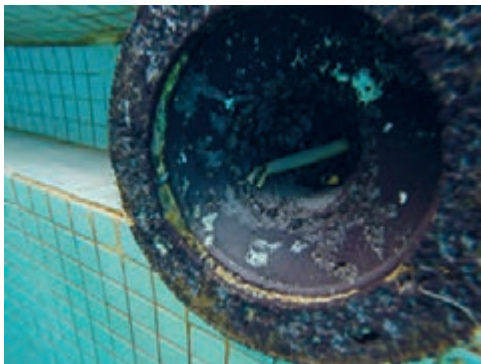
شکل ۴- روشنایی استخر معیوب است و رفع عیب آن باید با رعایت نکات حفاظتی و ایمنی باشد.
