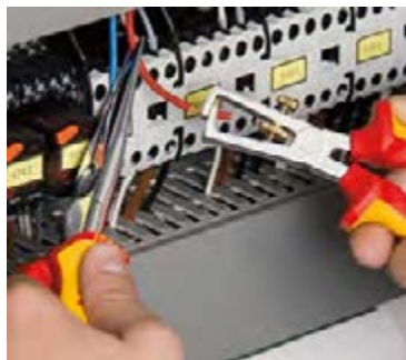
شکل ۹- روکش برداری با سیم لخت کن دستی
