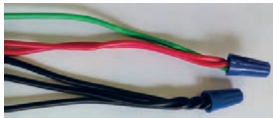
شکل ۴۳- بستن کانکتور پیچی
