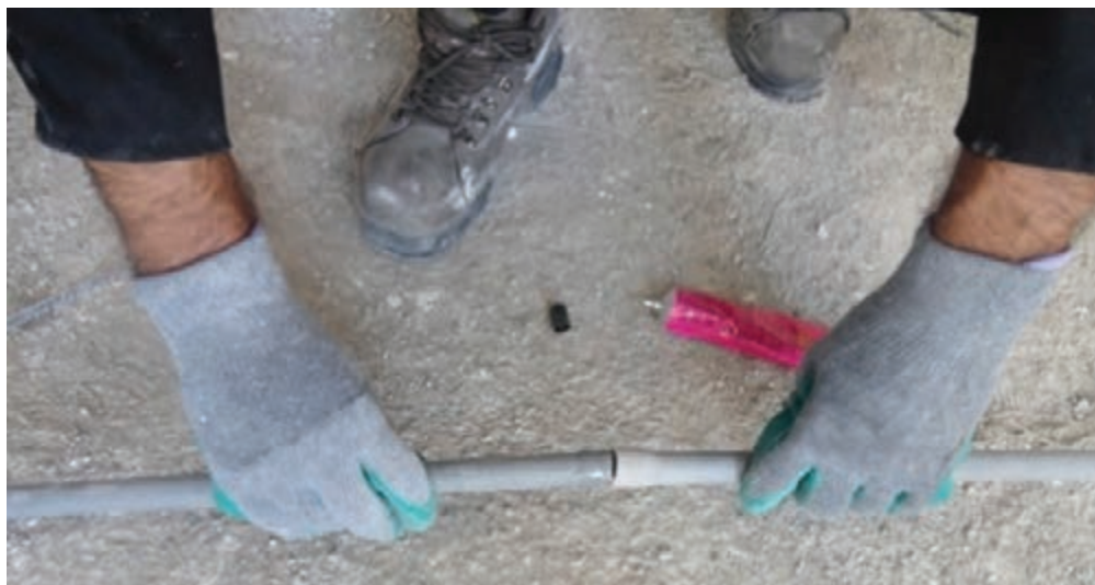
شکل ۴۵- اتصال لوله PVC
