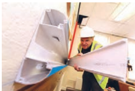
شکل ۴۳- نصب درپوش ترانکینگ
