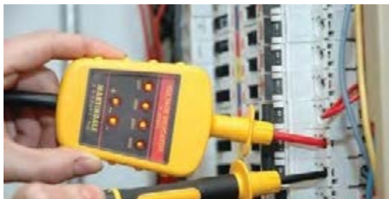
شکل ۵۴- تست تابلو با نشانگر ولتاژ
