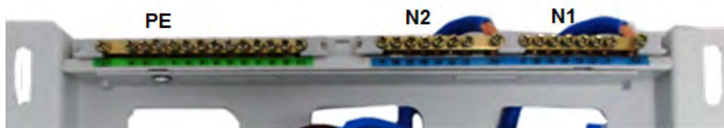
شکل ۸۰- ترمینال‌های نول و اتصال زمین
