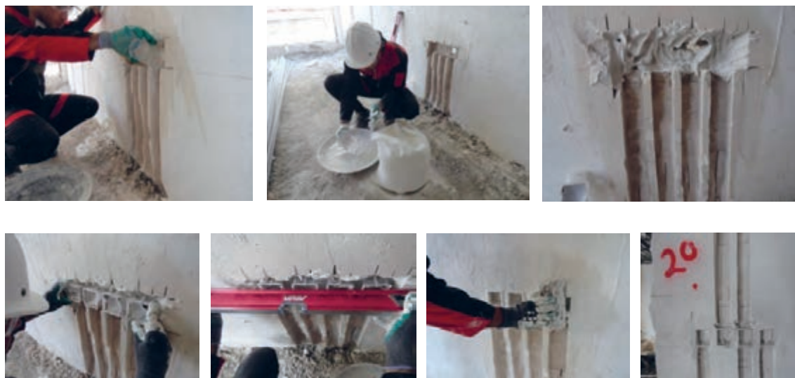
مراحل نصب قوطی کلید و پریز
