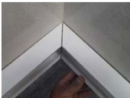
شکل ۵۰- برش و فارسی بر کردن ترانکینگ
