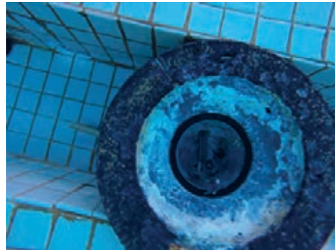
شکل ۴- روشنایی استخر معیوب است و رفع عیب آن باید با رعایت نکات حفاظتی و ایمنی باشد.
