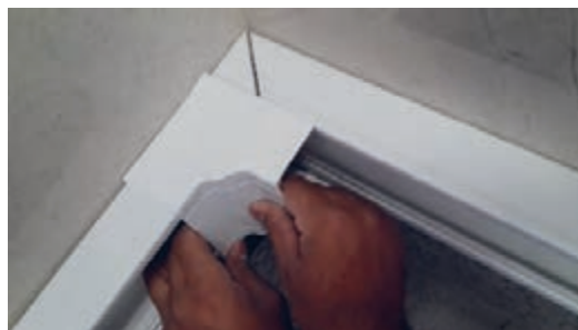
شکل ۵۱- نصب زانوی داخلی
