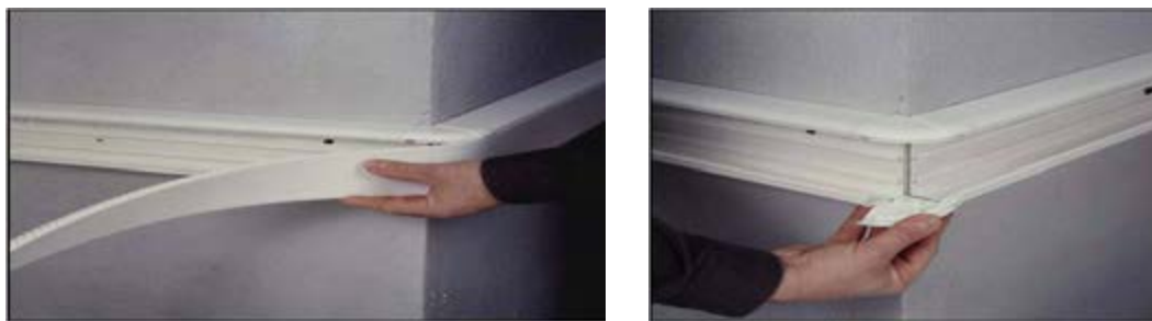
شکل ۴۴- نصب درپوش ترانکینگ زاویه‌دار
