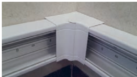
شکل ۵۱- نصب زانوی داخلی
