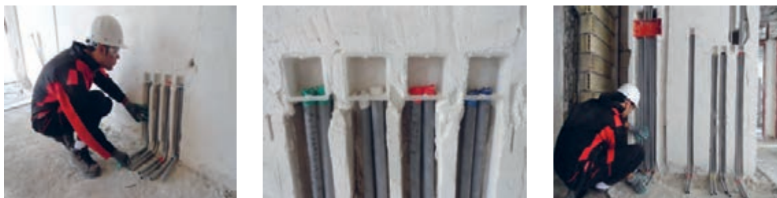
شکل ۴۶- نصب لوله در محل قوطی‌ها
