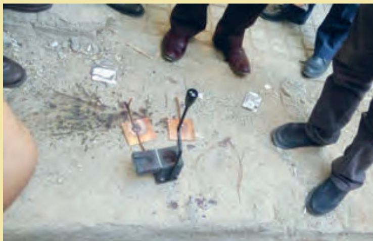
شکل ۹۸- رعایت فاصله از بوته مخصوص جوش اگزوترمیک
