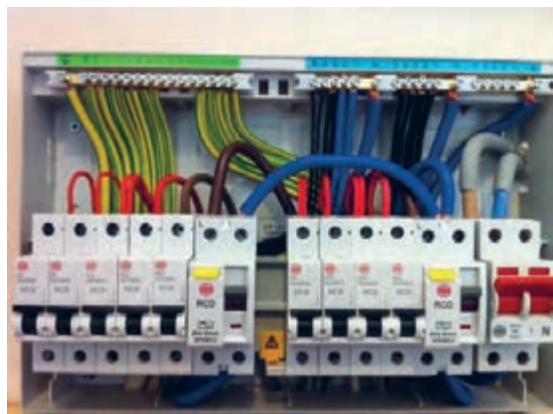
شکل ۴۹- اتمام سیم کشی قطعات تابلو
