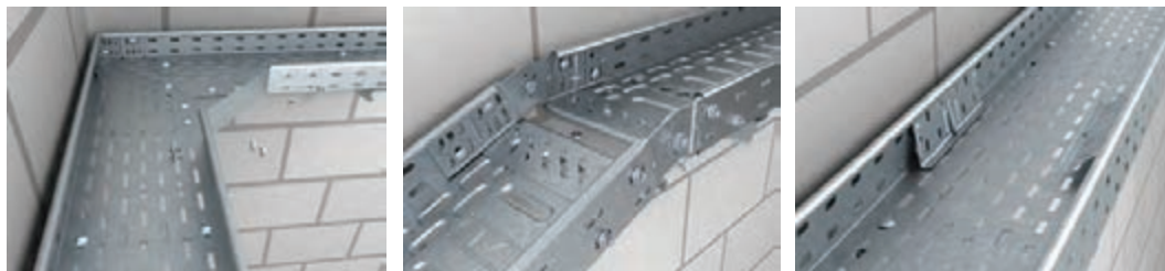
شکل ۴۴- اتصالات سینی کابل
