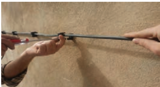
شکل ۳۷- کابل نصب شده روی دیوار
