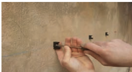
شکل ۳۶- نصب اولیه بست
