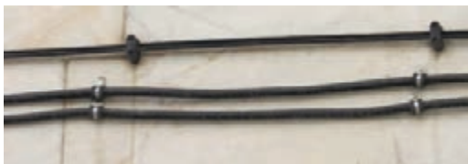
شکل ۲۷ - فاصله بین بست‌ها
