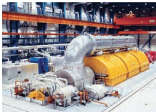
شکل ۲- ژنراتور سه فاز در نیروگاه
