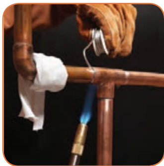
لجیم کاری نقره در لوله مسی
