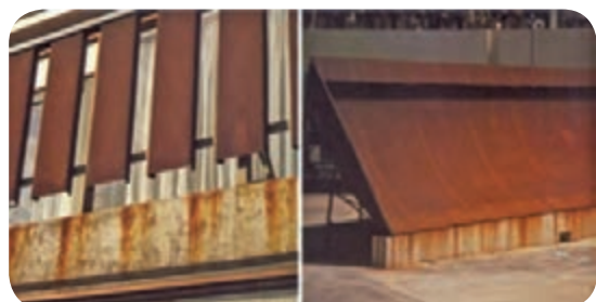
سطح زنگ زده ورق های آهنی در اثر قرارگرفتن در شرایط اتمسفر مرطوب
