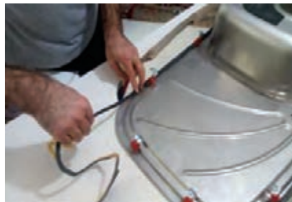
شکل ۱۰۴ - نصب نوار آب بندی پشت لبه سینک
