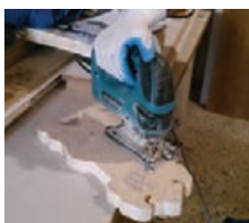
شکل ۱۷- عملیات برش کاری با اره عمودبر
