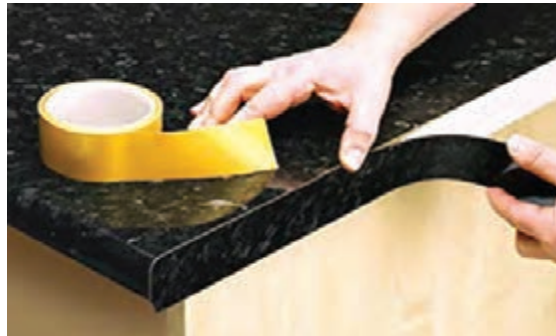
شکل ۱۱۹ - نصب نوار لبه صفحه تاپس
