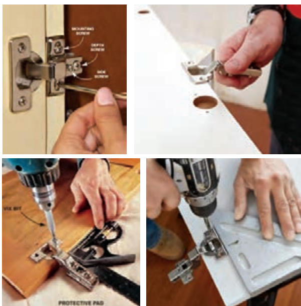
شکل ۴۹- نصب لولا روی در
