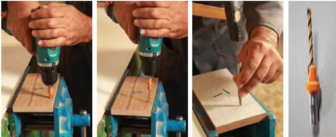
شکل ۵۲- شکل سوراخ کاری
