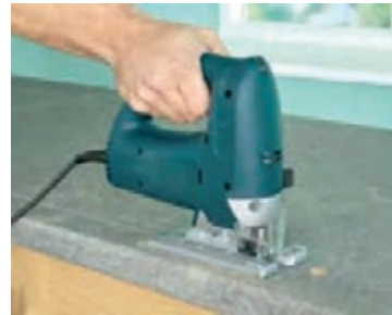
شکل ۱۰۱ - برش کاری محل قرارگیری سینک
