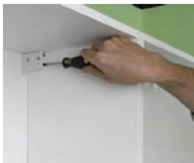
شکل ۲۳ - نصب کابینت با هنگر
