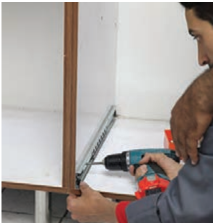
شکل ۸۲ - نصب قطعه یک تکه روی بدنه‌ها
