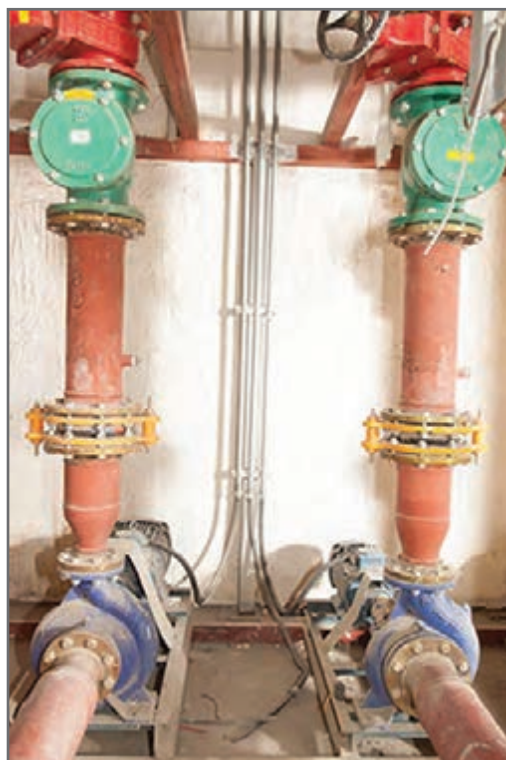
شکل ۳۲ - خط رانش پمپ زمینی
