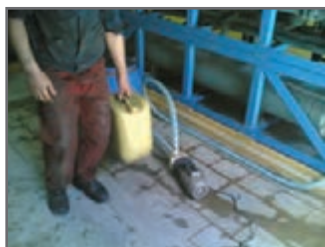
شکل ۲۵- مسیر ارتباطی پمپ و شلنگ به مبدل و بشکه اسید (پراتور آماده افزودن دیسکیلر به بشکه است)
