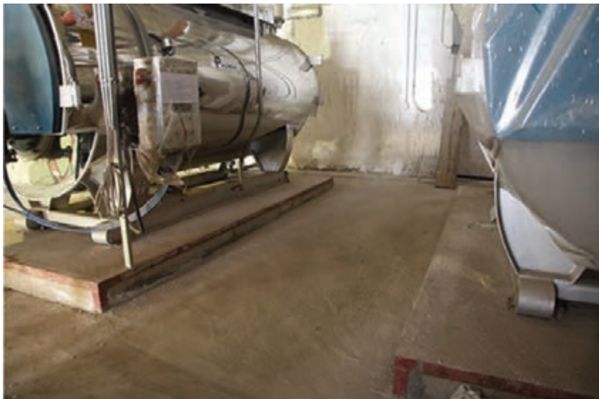
شکل ۱۴ - نصب دیگ روی فونداسیون
