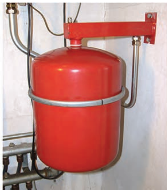
شکل ۱۶- استقرار مخزن انبساط بسته
