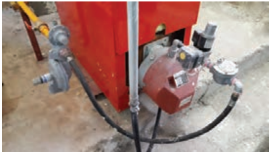
شکل ۲۹- اتصال مدار سوخت
