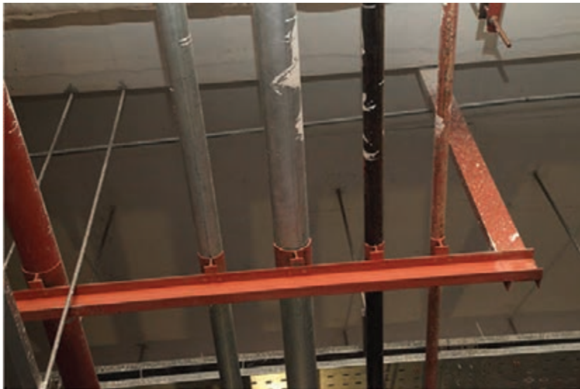
شکل ۱۶- آویز چند لوله‌ای
