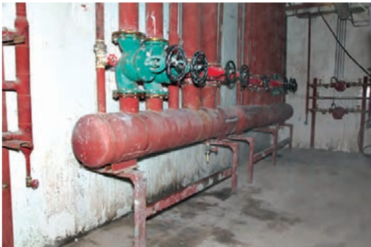
شکل ۱- نصب شیر تخلیه کلکتور
