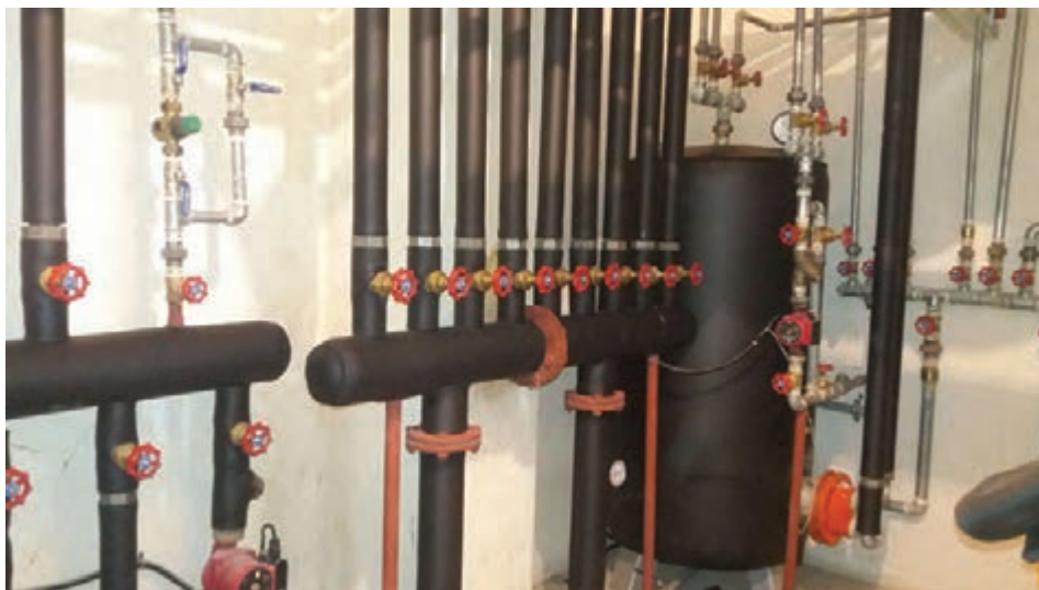
شکل ۲۵- عایق کاری در موتورخانه
