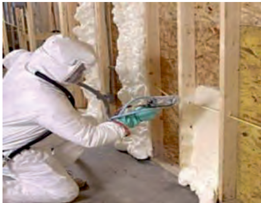
عایق‌بندی با نوعی فوم خمیری
