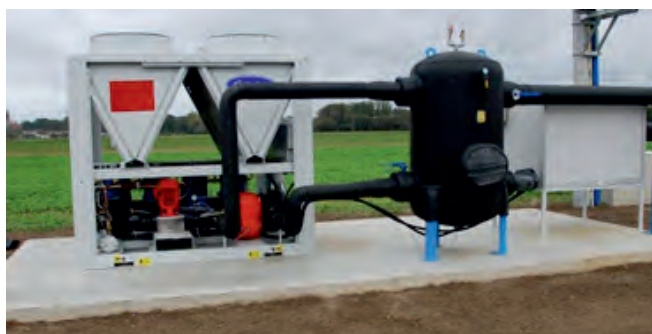
سیستم خنک‌کننده یک تولیدی قارچ دکمه‌ای
