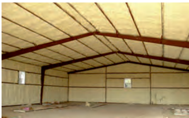
عایق‌بندی سقف و دیواره
