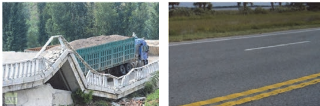
شکل ۱۳- تخریب رویه روسازی و ابنیه فنی
