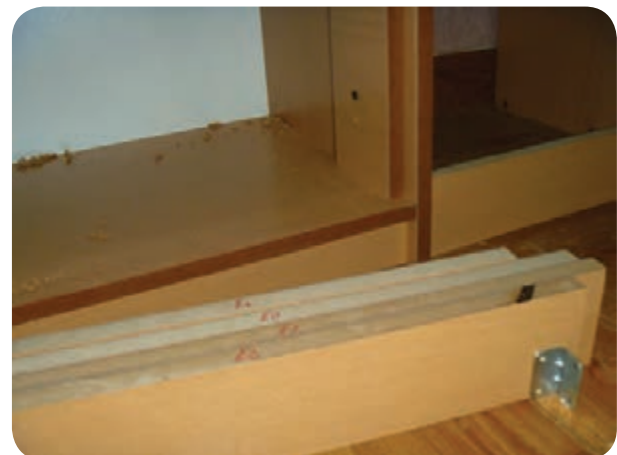
شکل ۱۶۶-۵- نصب پاسبانگ با استفاده از گونیای فلزی
