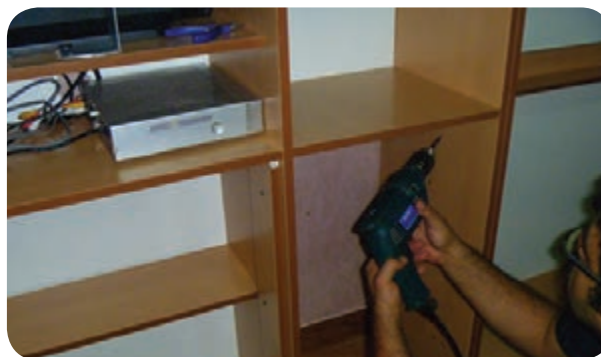
شکل ۱۷۲-۵- نصب صفحه میز آرایش
