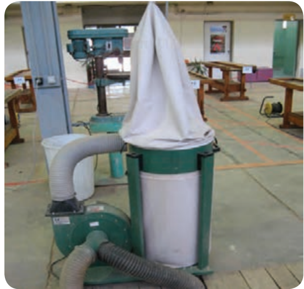
شکل ۲۴-۵- خروج ضایعات از طریق کانال پوشیده شده
