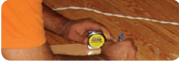
شکل ۱۲۳-۵- علامت‌گذاری و تعیین محل سوراخ‌ها
