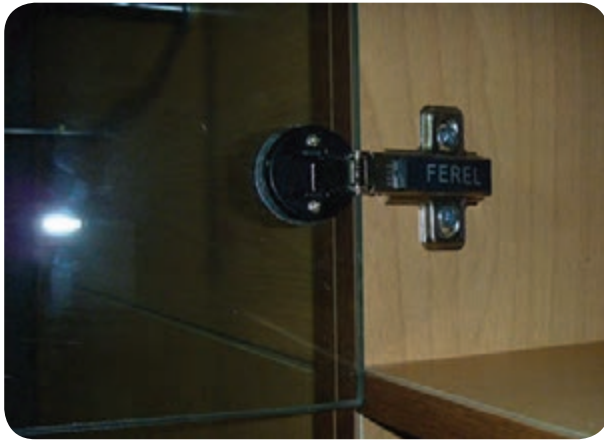
شکل ۱۴۳-۵- نصب لولای شیشه‌ای گازی برای در شیشه‌ای ویتیرین
