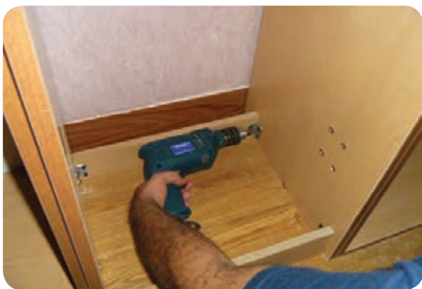
شکل ۱۸۰-۵- نصب پاسنگ‌ها
