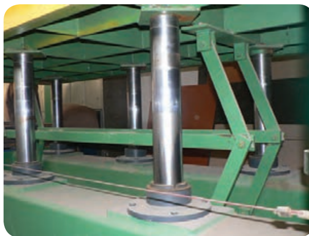
شکل ۸۹-۵- کنترل پیستون و سیلندرهای پرس
