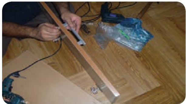
شکل ۱۵۹-۵- نصب دستگیره در کمد
