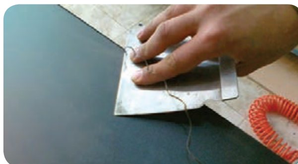
شکل ۲۵-۴ - نحوه برطرف کردن اضافه نوار با لیسسه
