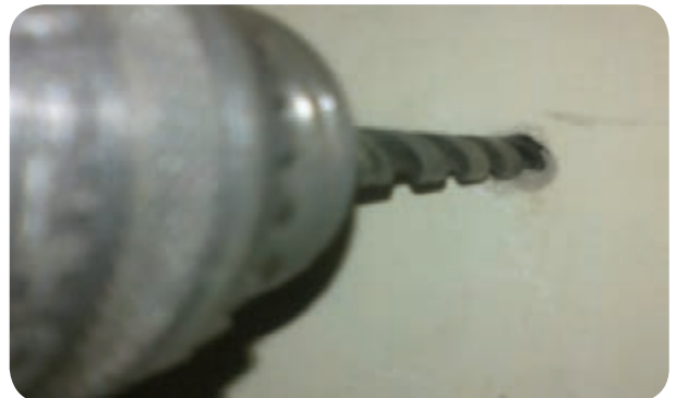
شکل ۶-۶ - سوراخکاری دیوار با مته الماسه مناسب
