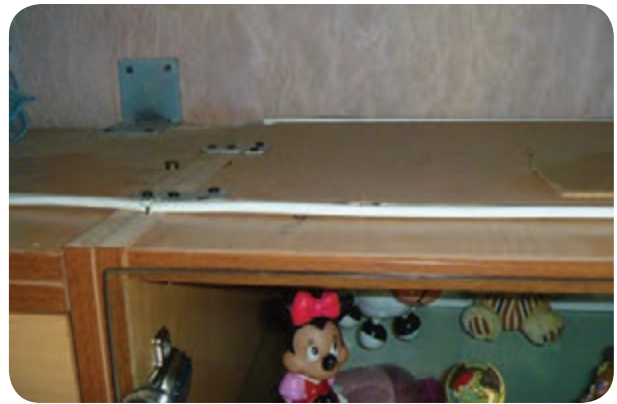
شکل ۵-۱۸۱- اتصال قسمت های مختلف دکور به یکدیگر و به دیوار
