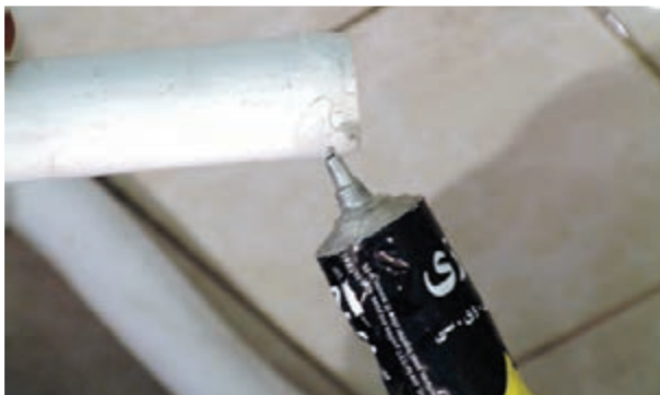
شکل ۳-۲۰۵- زدن چسب به لوله‌های تخلیه
