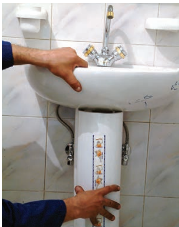
شکل ۳-۵۸- قرار دادن پایه‌ی دست‌شویی در زیر آن
