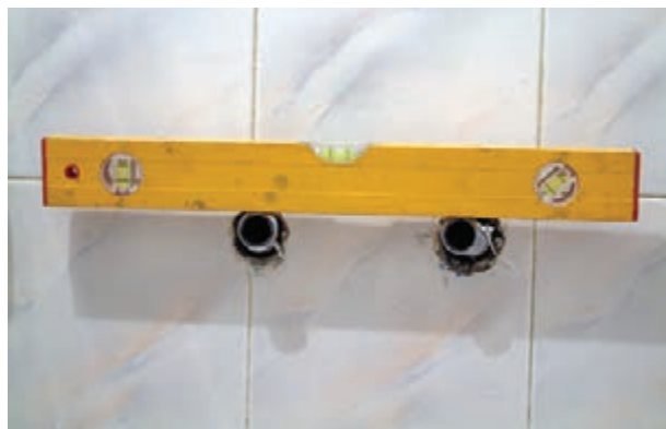
شکل ۲-۱۶۹- کنترل صاف بودن دنباله‌ها
