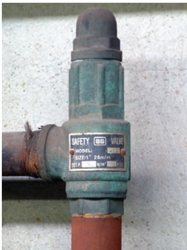
شکل ۱۰۶-۲ شیر اطمینان حساس در برابر فشار
