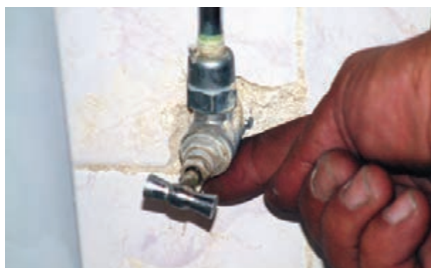
شکل ۱۴۷-۲- کنترل نشت آب از محل اتصال
