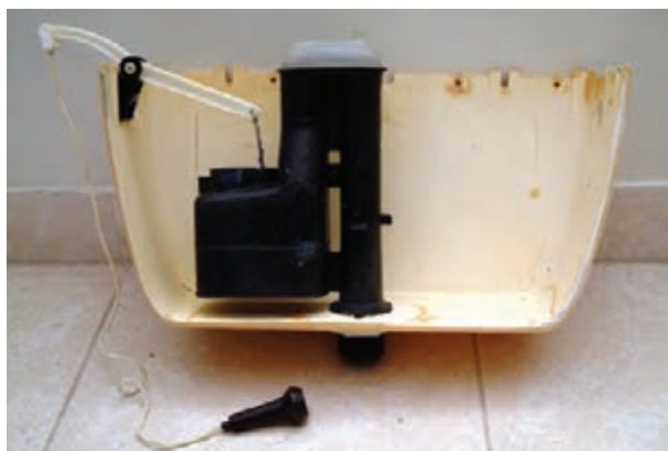
شکل ۳-۲۰۷- نصب پمپ تخلیه درون مخزن فشار
