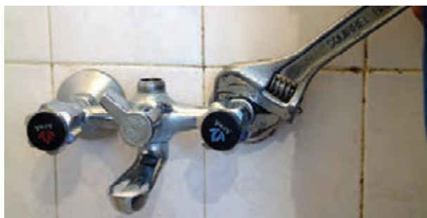
شکل ۲-۲۰۶ سفت کردن مهره‌های شیر با آچار
