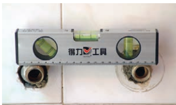
شکل ۲-۲۰۳- کنترل تراز بودن دنباله‌ها
