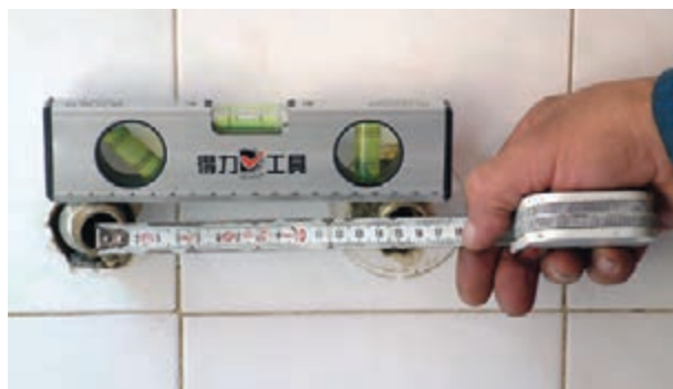
شکل ۲-۱۸۶- کنترل صاف بودن و اندازه‌ی دنباله‌ها
