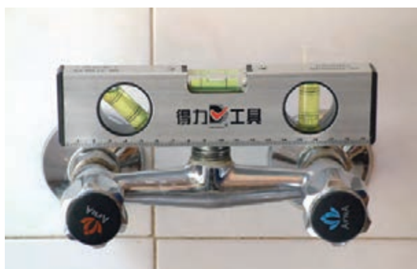
شکل ۱۷۴-۲ سنجش تراز بودن شیر مخلوط دیواری
