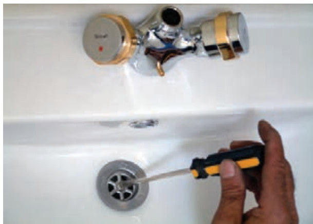
شکل ۳-۴۰ نصب زیراب بر روی دست شویی
