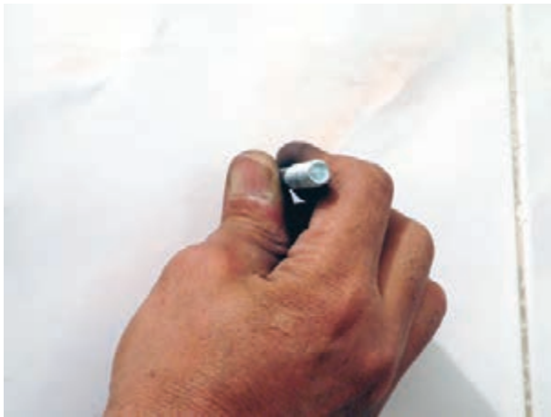
شکل ۳-۴۳- بستن پیچ‌ها در درون رولپلاک‌ها با دست
