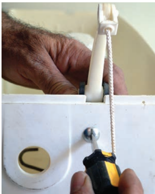
شکل ۳-۲۰۹- اتصال اهرم به بدنه‌ی مخزن فشاری
