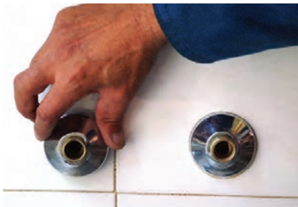
شکل ۲-۱۷۰- بستن کاسه‌ها به دنباله‌ها با دست
