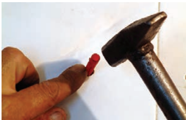
شکل ۱۹۳-۲- کوبیدن رولپلاک درون سوراخ
