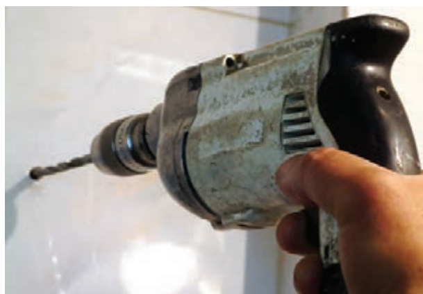
شکل ۲-۱۹۲- سوراخ کردن محل نصب بست آویز
