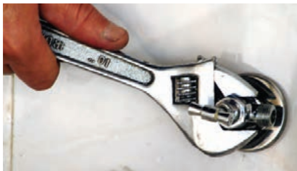
شکل ۱۴۴-۲- سفت کردن شیر پیسوار با آچار فرانسه
