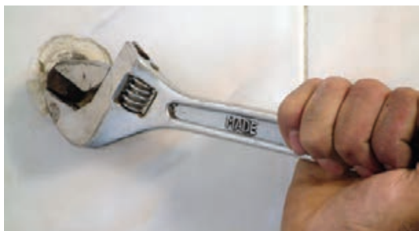
شکل ۱۹۸-۲- باز کردن درپوش‌ها
