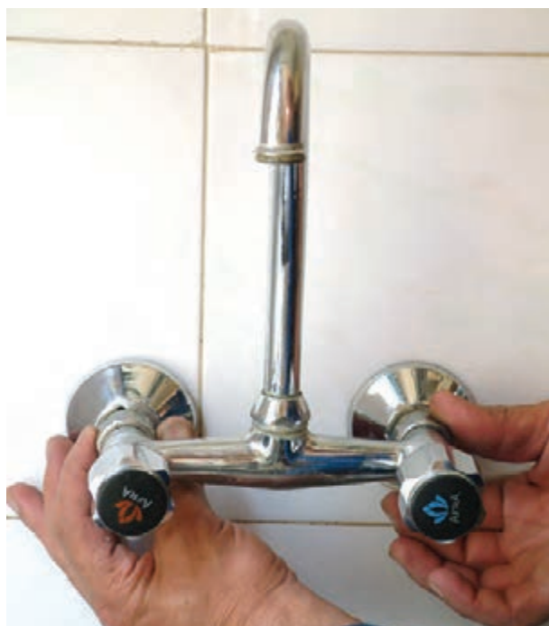
شکل ۱۷۲-۲ پیچیدن مهره‌ها به دنباله‌های شیر مخلوط
