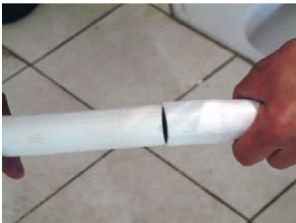
شکل ۳-۲۰۶- جا زدن لوله‌های تخلیه در درون یکدیگر
