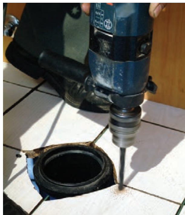
شکل ۲۴۶-۳- سوراخ‌کاری محل‌های علامت‌گذاری شده
