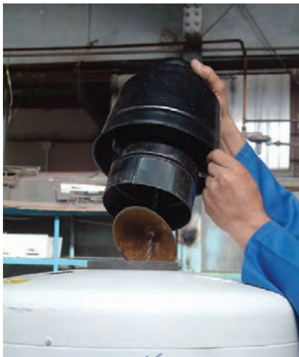
شکل ۱۱۵-۱ برداشتن کلاهک تعدیل از روی دودکش
