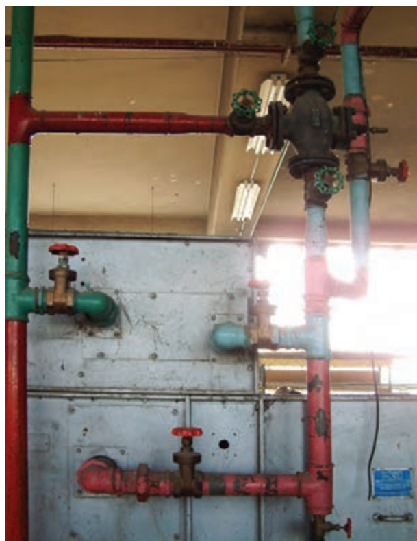
شکل ۲-۸۳ – مورد استفاده‌ی شیر فلکه در تهویه‌ی مطبوع
