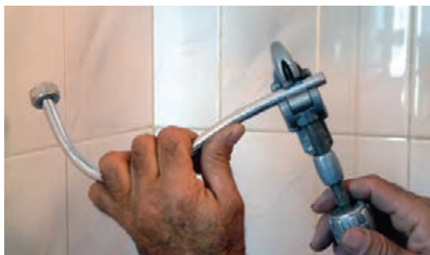
شکل ۲۲۲-۳- بریدن لوله‌ی پیسوار به وسیله‌ی لوله‌بر
