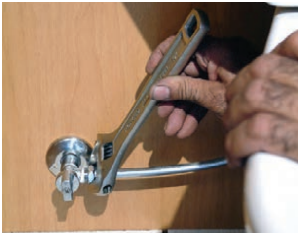
شکل ۳-۲۵۶- سفت کردن مهره‌ی شیر پیسوار
