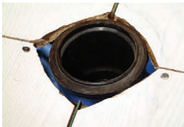
شکل ۲۴۴-۳- قراردادن بوگیر در داخل زانویی
