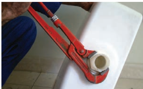
شکل ۳-۲۰۸- سفت کردن مهره‌ی پمپ تخلیه
