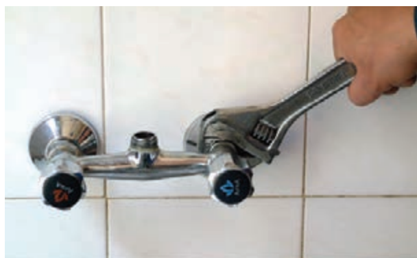
شکل ۱۷۳-۲ سفت کردن مهره‌ها به وسیله‌ی آچارفرانسه
