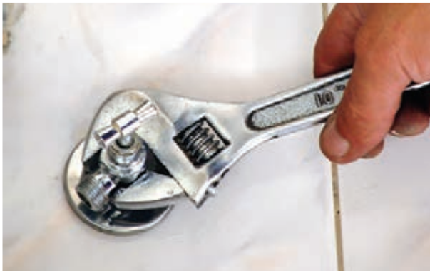
شکل ۲۲۰-۳ سفت کردن شیر پیسوار با آچار فرانسه
