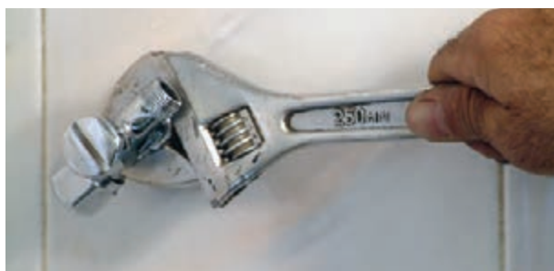
شکل ۳-۴۸ سفت کردن شیر پیسوار با آچار فرانسه
