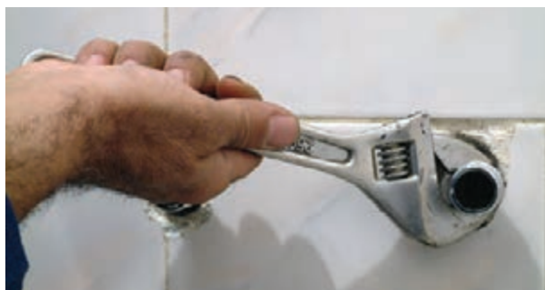
شکل ۱۶۷-۲ سفت کردن دنباله‌ها با آچارفرانسه
