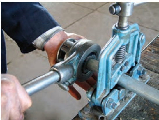
شکل ۱۵۱-۵- حديدۀ کردن لوله‌ها
