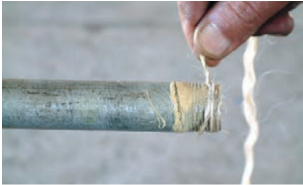
شکل ۵-۵۴- پیچیدن کنف بر روی سردنده
