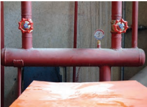
شکل ۳-۵- استفاده از اتصال جوشی در حرارت مرکزی
