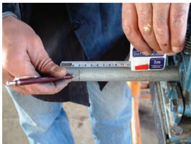
شکل ۷-۱- علامت‌گذاری کردن لوله با متر و مداد
