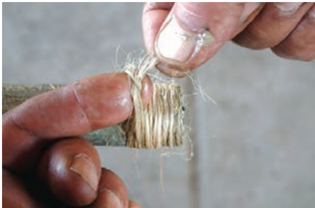
شکل ۵-۵۵- گره زدن انتهای پیچیدن کنف
