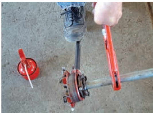
شکل ۱۲۰-۵- عمل حدیده کاری لوله
