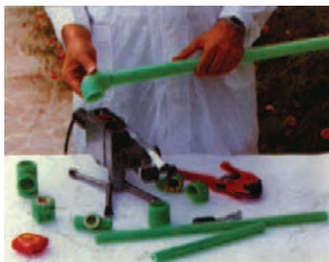
شکل ۲۹-۵- اتصال لوله و فیتینگ پلی‌پروپیلنی پس از خنک‌شدن
