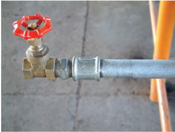
شکل ۸-۴- اتصال دنده‌ای
