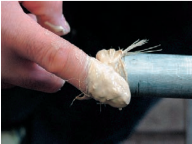
شکل ۵-۹۰- خمیر و کف کردن سردنده
