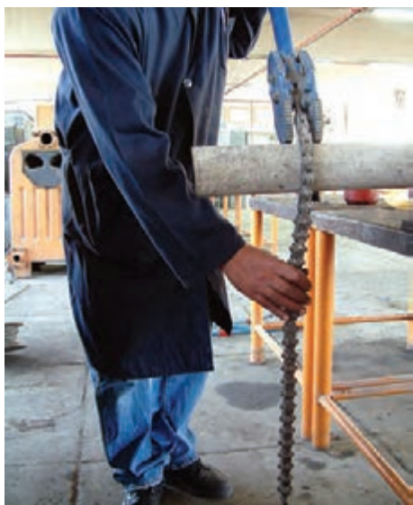
شکل ۵-۶۸- استفاده از آچار زنجیری برای کاربر روی لوله‌های قطور
