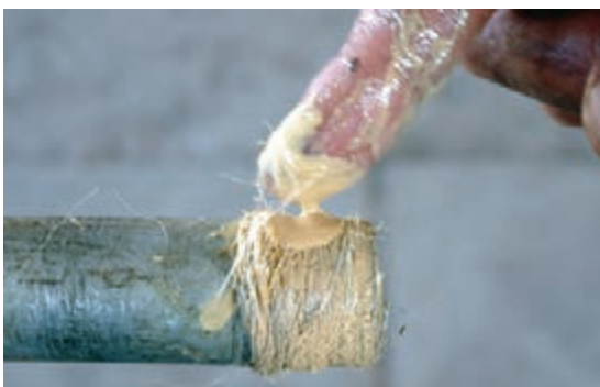
شکل ۱۵۲-۵- خمير و کف کردن سردندۀها
