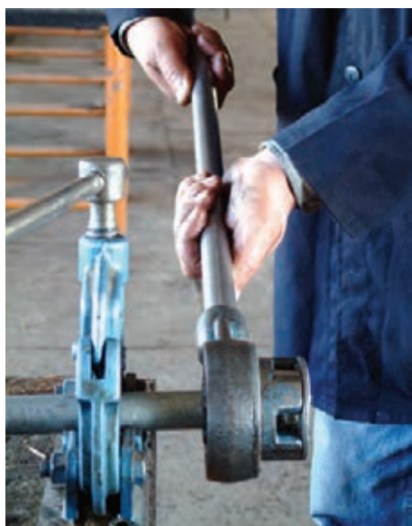
شکل ۴-۵۰- باز کردن حدیده از لوله
