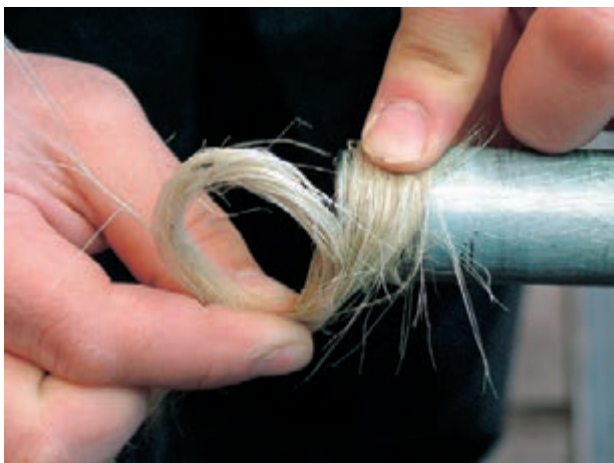
شکل ۱۳۸-۵- بیچیدن مواد آب‌بندی به سردنده‌ها
