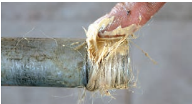
شکل ۵-۵۷- مالیدن خمیر آب‌بندی بر روی کنف
