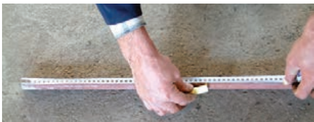
شکل ۳-۵۴- خط‌کشی لوله و تعیین محل‌های خم
