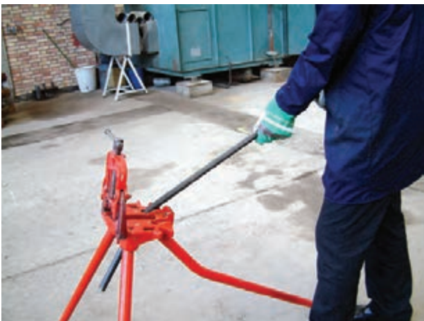
شکل ۳-۹- خم‌کاری لوله به وسیله‌ی گیره‌ی صحرائی
