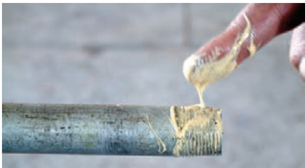
شکل ۵-۵۳- مالیدن خمیر بر روی سردنده
