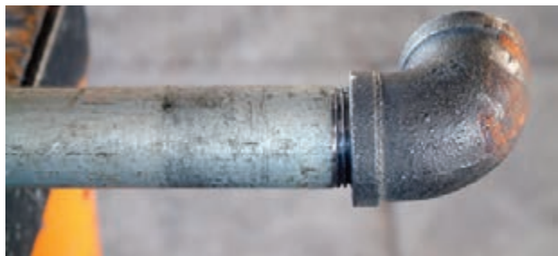
شکل ۵-۹۹- سفت کردن مناسب فیتینگ به لوله
