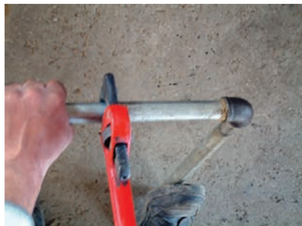
شکل ۱۲۶-۵- سفت کردن لوله به فیتینگ به وسیله‌ی یک عدد آچار لوله‌گیر
