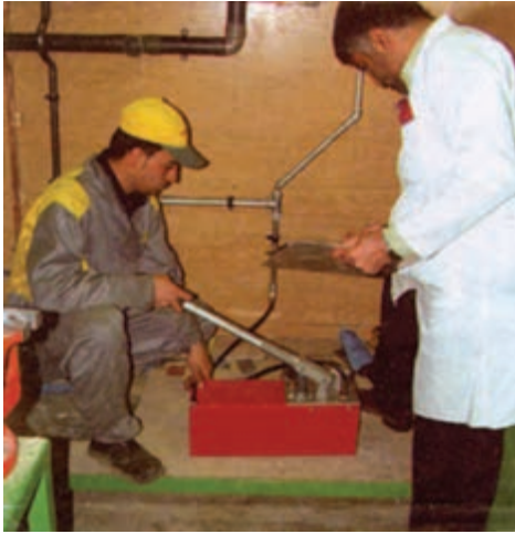
شکل ۵-۹۳- نحوه‌ی آزمایش با پمپ آزمایش دستی
