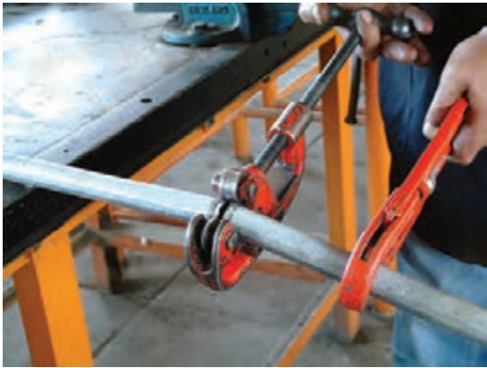
شکل ۱۱۷-۵- بریده شدن لوله و خاتمه‌ی کار
