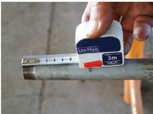
شکل ۱۲۸-۴- اندازه‌گیری لوله‌ی حدیده شده
