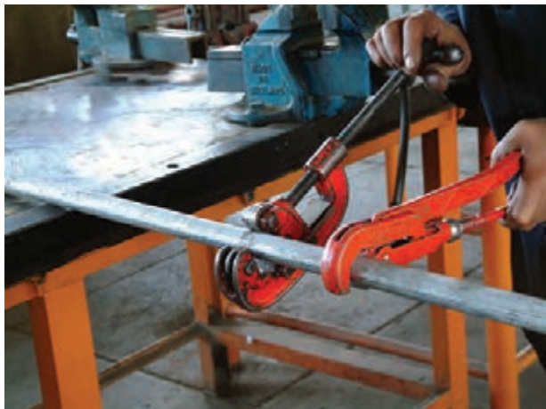
شکل ۱۱۵-۵- شروع برش‌کاری لوله بدون استفاده از گیره‌ی لوله
