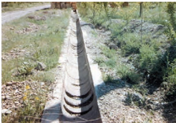
شکل ۲-۲- کانال با مقطع دوزنقه‌ای
