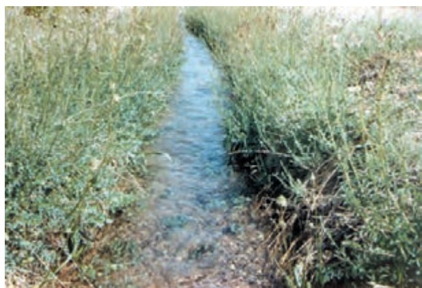
شکل ۱۵-۲- نهر زراعی بدون پوشش
