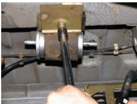
شکل (۲-۶۸) نصب فیلتر جدید
