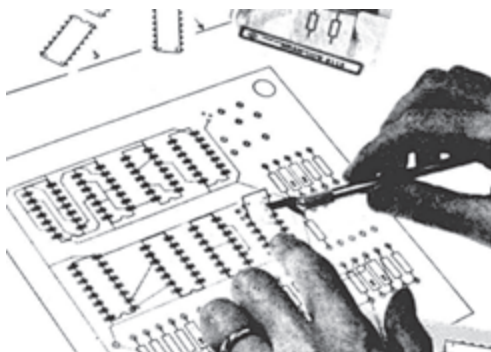
شکل ۷-۳۵ نحوه‌ی چسباندن لتراست مربوط به پایه قطعات
