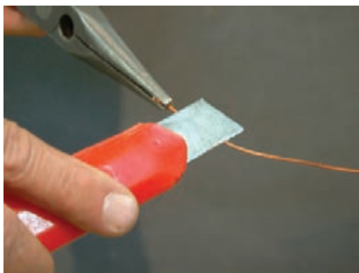
شکل ۴-۱-ج - پاک کردن لاک به روش تراشیدن
