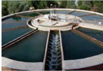
آب در تصفیه‌خانه
