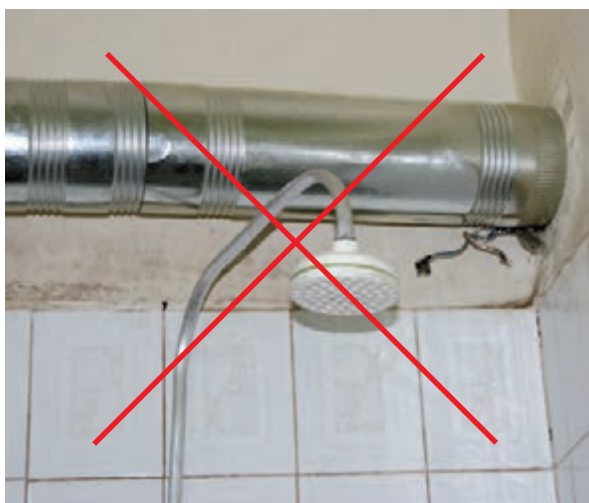
شکل ۳-۱۱ عبور غیر مجاز دودکش
