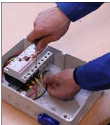
شکل ۲۲- نصب کلید جریان باقیمانده (نشتی)
