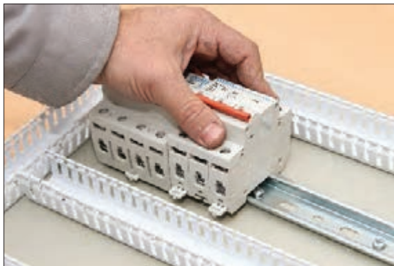
شکل ۴۶- نصب قطعات روی ریل
