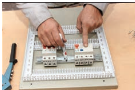
شکل ۴۲- محل نصب ریل فلزی
