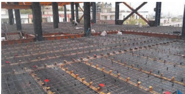
شکل ۳۲ ▲ سقف مرکب به همراه برشگیرها
