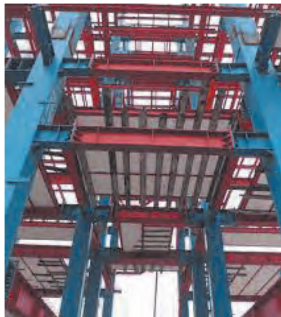
شکل ۶۰ ▲ قاب خمشی
