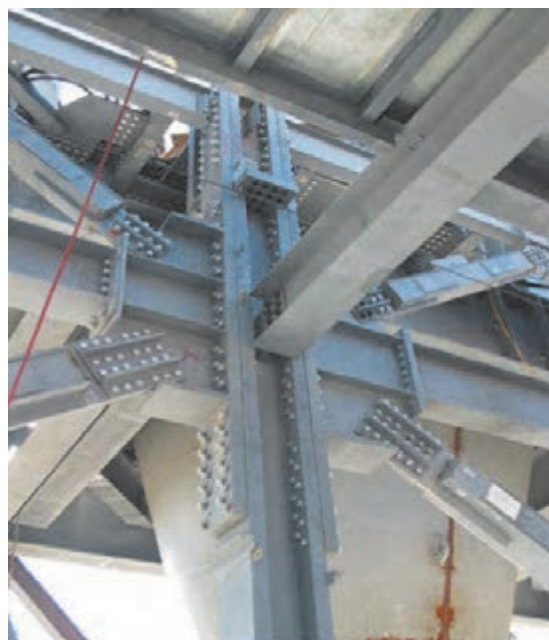
شکل ۵۱ ▲ اتصال مهاربندی
