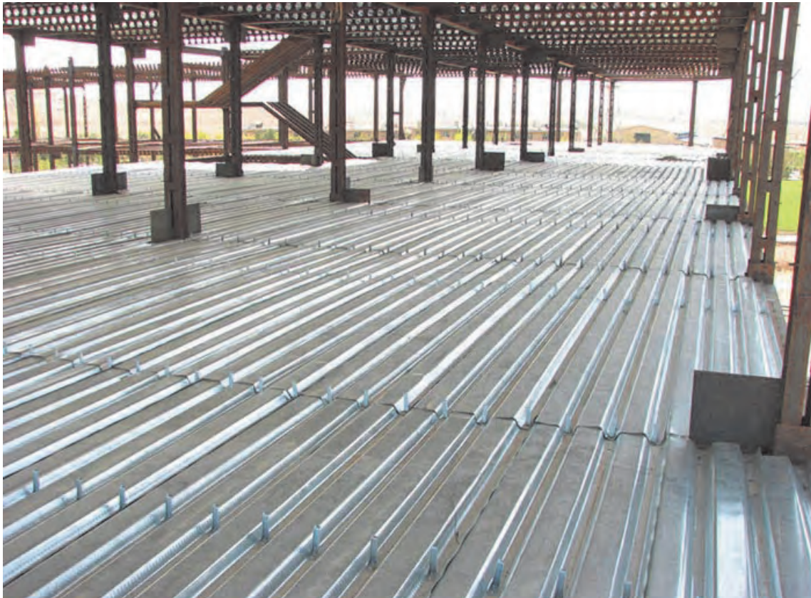
شکل ۳۳ ▲ سقف عرشه فولادی
