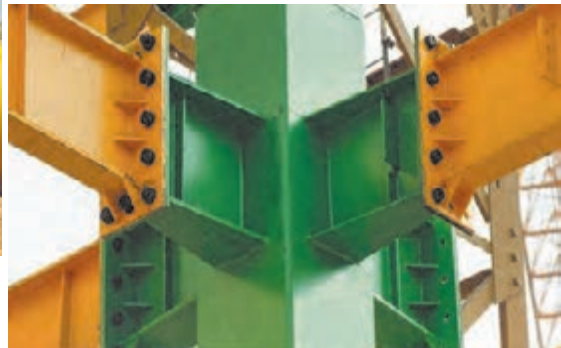
شکل ۵۰ ▲ انواع اتصال فلنجی
