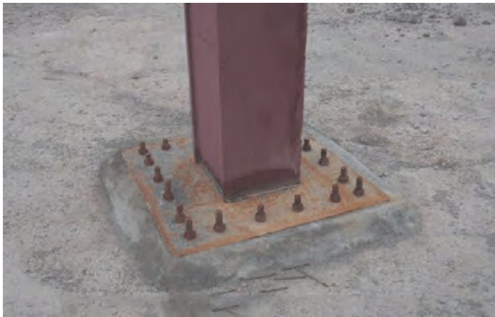
شکل ۴۹ ▲ اتصال مستقیم ستون به کف ستون
