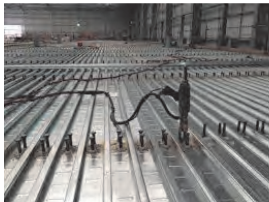
شکل ۳۴ ▲ روش نصب گل‌میخ روی سقف عرشه فولادی
