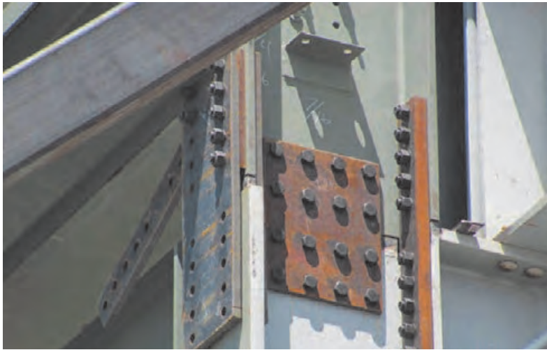
شکل ۵۷ وصله پیچی ستون
