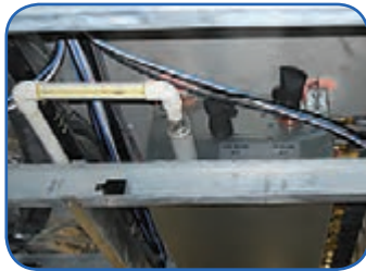
شکل ۸- نمونه اتصال لوله تخلیه به تشتک
