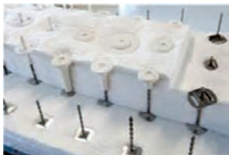
ب) استفاده از انکر سرامیکی برای نصب پتوی عایق
