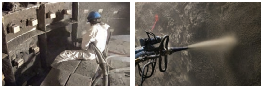
شکل ۲۸- نصب جرم با روش پاشش
