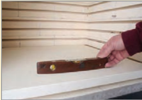
شکل ۲۸- بررسی تراز بودن کف کوره کارگاهی
