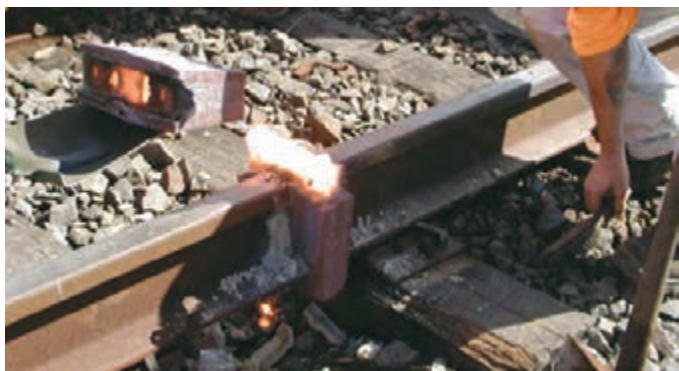
شکل ۲۳- شکستن قسمت فوقانی قالب
