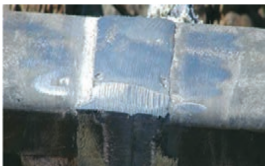
شکل ۲۶- نمایی از سطح جوش
