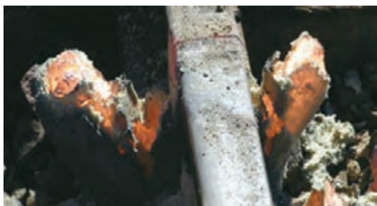
شکل ۲۴- برش گرده اضافی جوش
