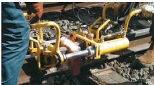
شکل ۲۴- برش گرده اضافی جوش
