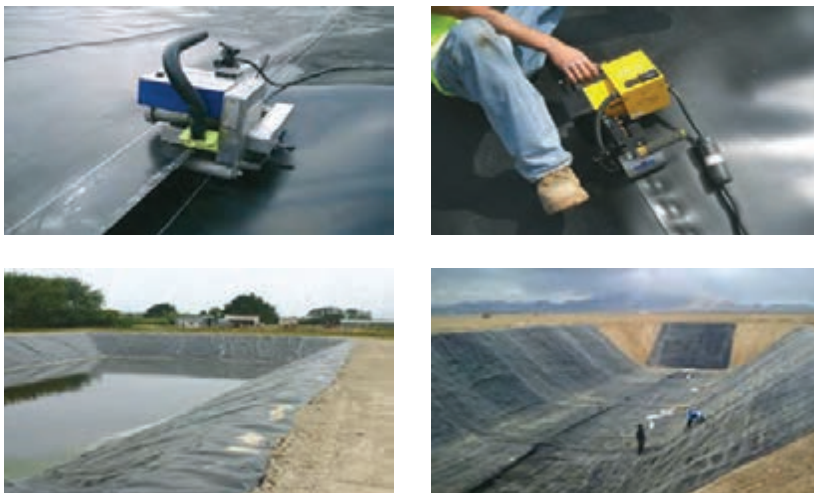
شکل ۱۴- جوشکاری عایق‌های پلاستیکی (ژئوممبران) استخرهای ذخیره آب
