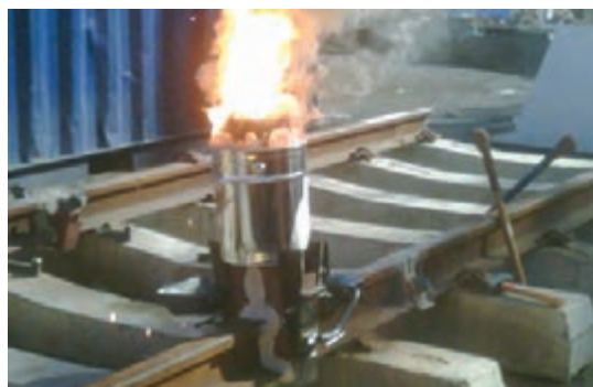
شکل ۲۱- نمایی از انجام واکنش ترمیت
