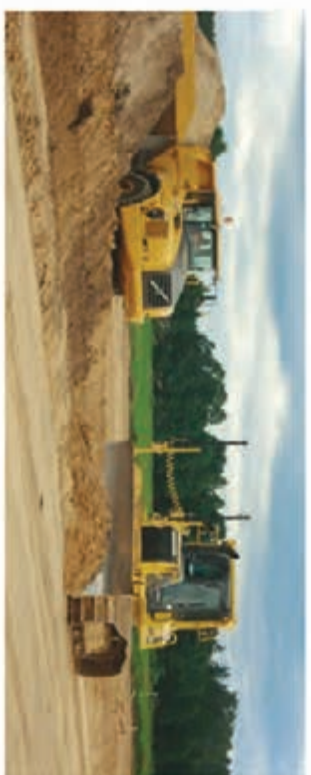
بلدوزر و کامیون در حال تسطیح محوطه
