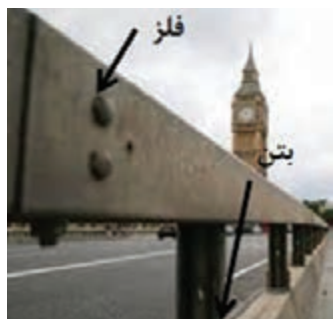
شکل ۳۳- نمونه حفاظ ترکیبی بتنی و فلزی
