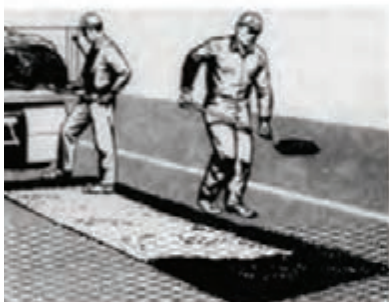
پر کردن محدوده لکه گیری با آسفالت
