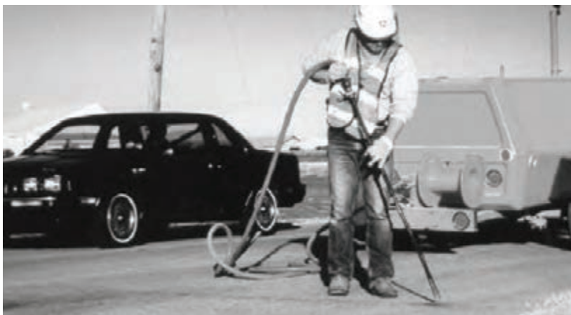
شکل ۲۱- تمیز کردن ترک با فشار بالای هوا با استفاده از کمپرسور هوا
