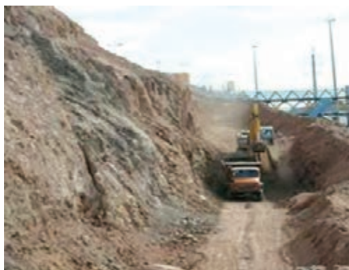
شکل ۱- اجرای عملیات خاک‌برداری
