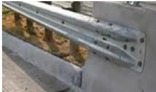
شکل ۸۱ - ناحیه انتقالی حفاظ دو موج به نیوجرسی
