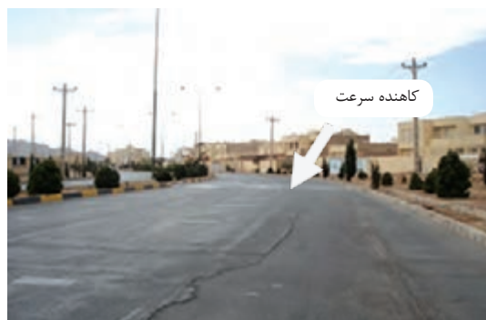
شکل ۳۱- دید ضعیف خطوط میانی و خطوط هشدار دهنده موجود بر روی سرعت‌کاه در روز
