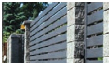
شکل ۱۱- دیوارهای حایل ژئوبلوک
