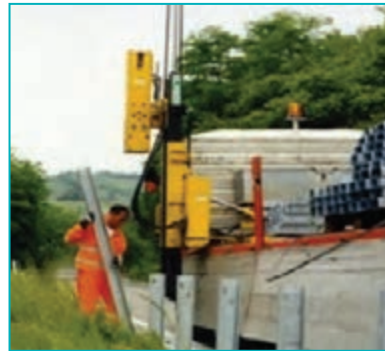
شکل ۳۴- چکش هیدرولیکی گاردریل کوب
