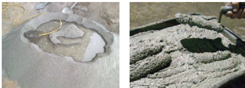
شکل ۱۸- طرز تهیه ملات ماسه سیمان
