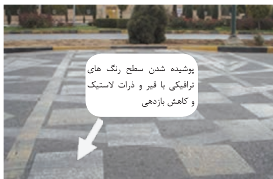
شکل ۳۱- دید ضعیف خطوط میانی و خطوط هشدار دهنده موجود بر روی سرعت‌کاه در روز
