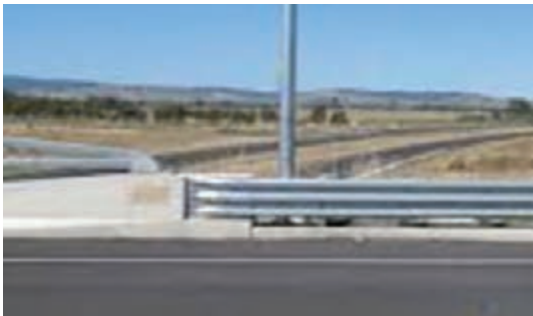
شکل ۸۲ - ناحیه انتقالی حفاظ سه موج به نیوجرسی
