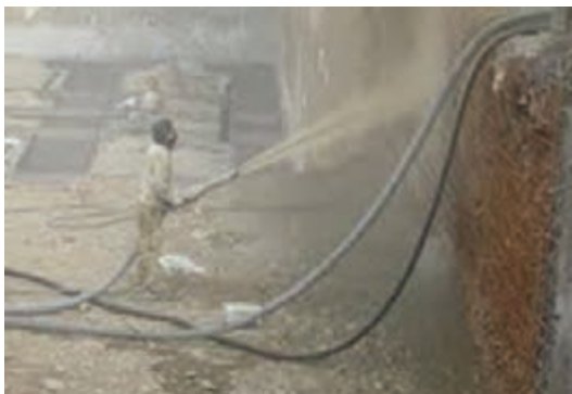
شکل ۲۰- اجرای بتن پاشی (شاتکریت) در بدنه سد
