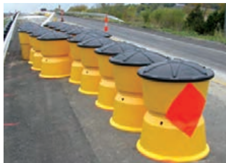
شکل ۱۰- ضربه گیرهای وزنی بشکه‌ای و مکعب مستطیلی
