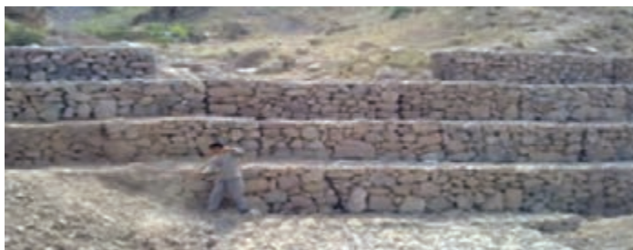
شکل ۳- دیوارهای توری سنگی (گابیون بندی) دیواره‌های ریزشی کوه
