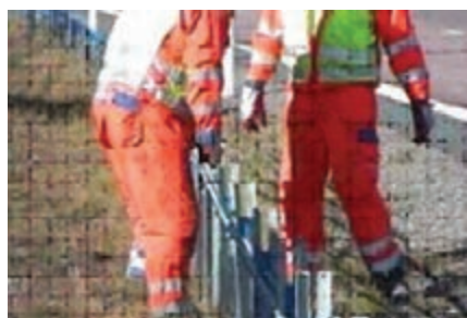
شکل ۶۷- تعمیر حفاظ کابلی
