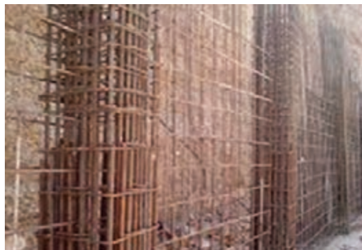
شکل ۲۰- اجرای بتن پاشی (شاتکریت) در بدنه سد
