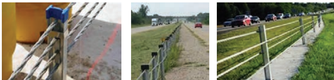
شکل ۴۶- نمونه‌هایی از اتصال کابل به پایه‌ها
