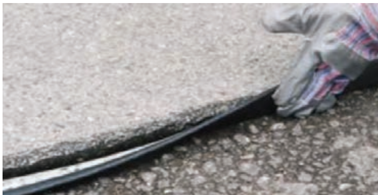
شکل ۴۸- نصب نوار لکه‌گیری بر روی دیواره آسفالت
