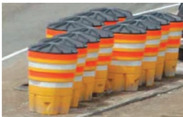
شکل ۲۷- طریقه نصب و چیدمان صحیح ضربه‌گیرهای بشکه‌ای
