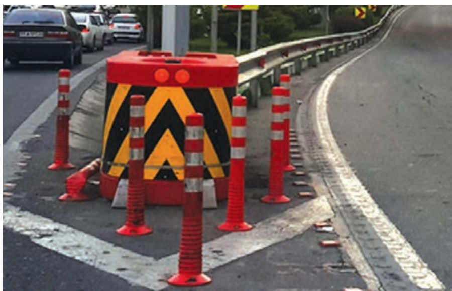
شکل ۲۱ - اجزای ضربه گیر ریلی در تهران
