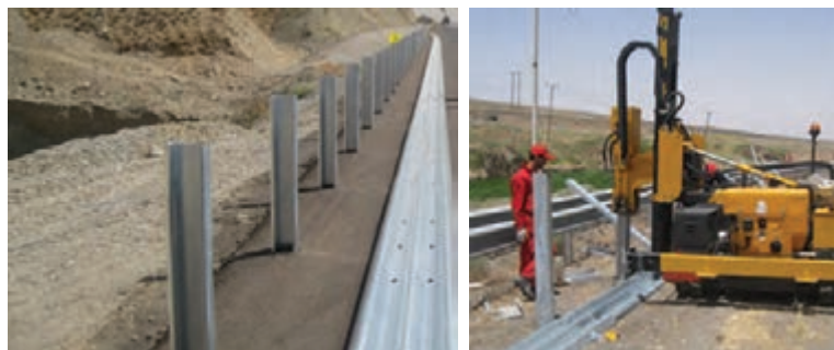
شکل ۴۲- پایه‌کوبی بعد از ریلی کردن سپری‌ها
