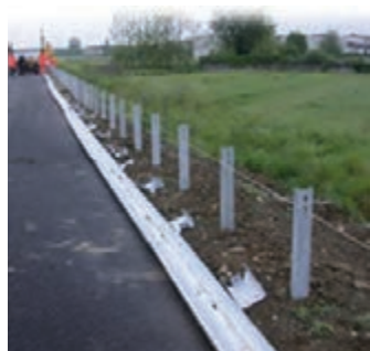
شکل ۴۳- نمونه‌ای از نصب پایه‌های گاردریل با ریسمان‌کشی
