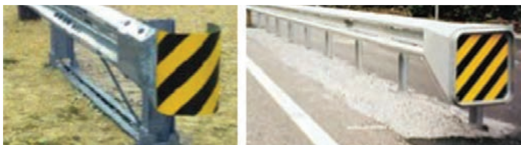
شکل ۷۳- نمونه‌هایی از مهارهای انتهایی و ضربه‌گیر
