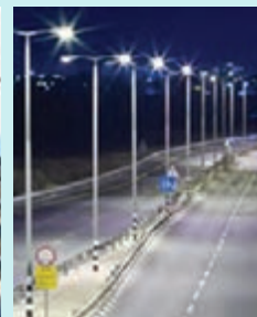
شکل ۷۶- ایمن سازی چراغ برق
