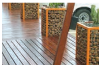
شکل ۷- محوطه‌سازی با اجرای جعبه‌های گابیونی معابر
