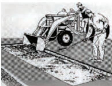
برداشتن لایه های آسفالتی و اساس
