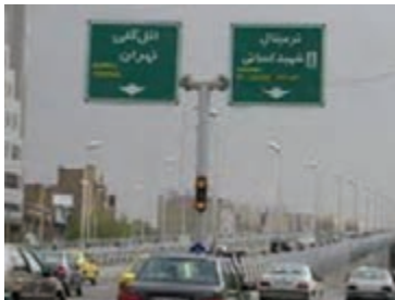
شکل ۲۹ - نمونه‌ای از تابلوهای هدایت مسیر / خروجی (صلیبی)
