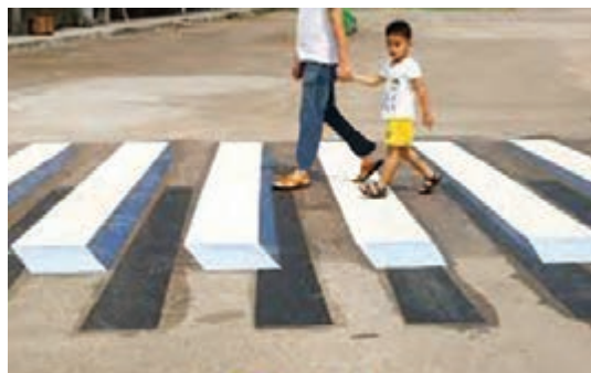
شکل ۴- ترسیم موانع در مسیر به منظور کاهش سرعت خودرو
