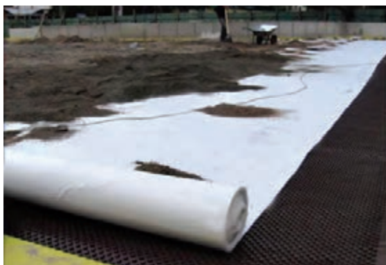
قرارگیری رول ژئوتکستایل در زیر بستر رشد
