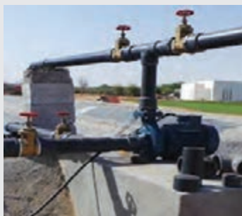
شکل ۱۸- شیرفلکه لوله رانش
