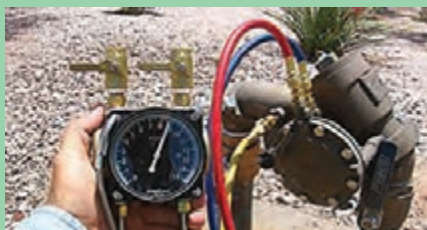
شکل ۱۷- تنظیم فشار شیر فشارشکن
