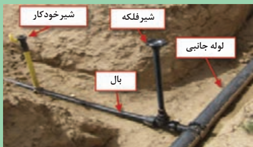
شکل ۱۱- محل شیر فلکه روی بال
