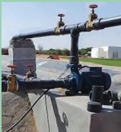
شکل ۱۰- شیر فلکه لوله رانش
