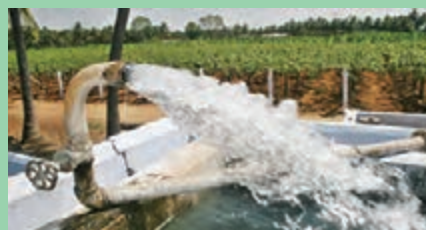
شکل ۱۶- لوله برگشت آب
