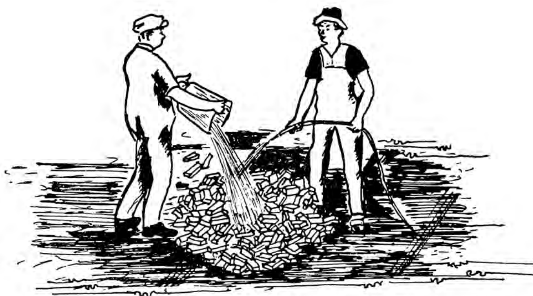
شکل ۳۷ ▲ زنجاب کردن آجر
