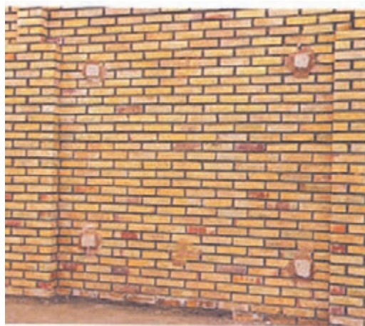
▲ شکل ۲۱ کرم‌بندی ابتدا و انتهای دیوار
