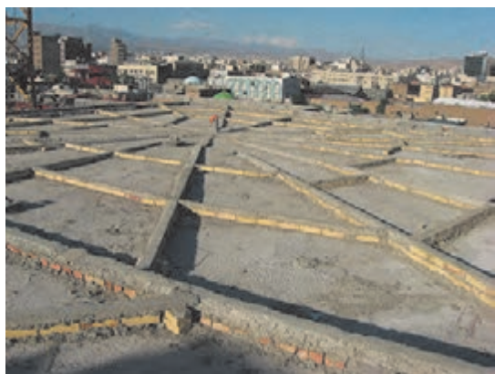
شکل ۱۴ ▲ کرم‌بندی و شمشه‌گیری بین آن‌ها
