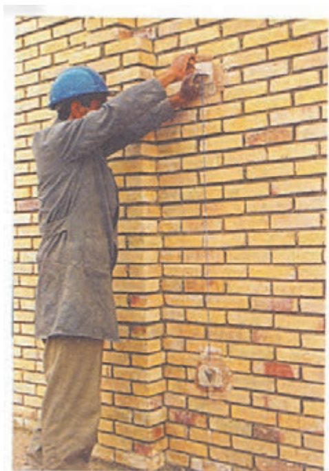
▲ شکل ۲۰ شاقولی کردن کرم‌ها
