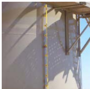
شکل ۲۲-۴- ارتفاع سنج مغناطیسی روی مخزن
