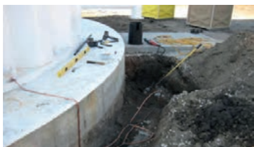
شکل ۴-۲۵- تخلیه الکتریسیته ساکن بدنه مخزن به زمین
