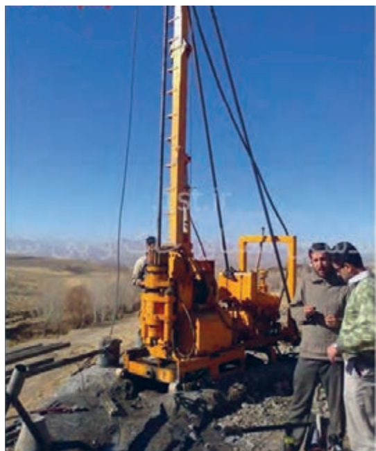
دستگاه حفاری مستقر شده بر روی فونداسیون
