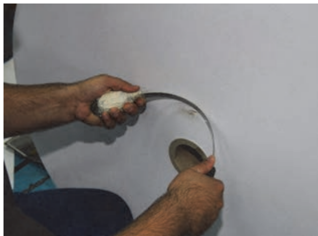
شکل ۵- برطرف کردن آسیب روی بدنه رول
