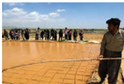
شکل ۳۲- برش دادن گل درون حوضچه
